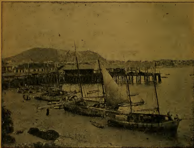
Bahía de Panamá.—Embarcadero de Playa Prieta en la bajamar.
